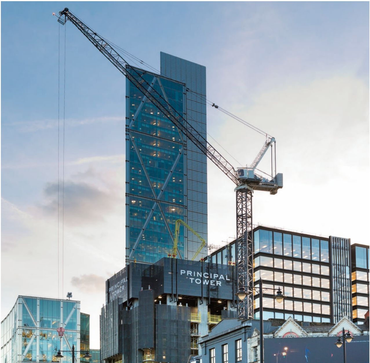
Ein Liebherr-Turmdrehkran im Einsatz am Principal Tower in London (Grossbritannien)
