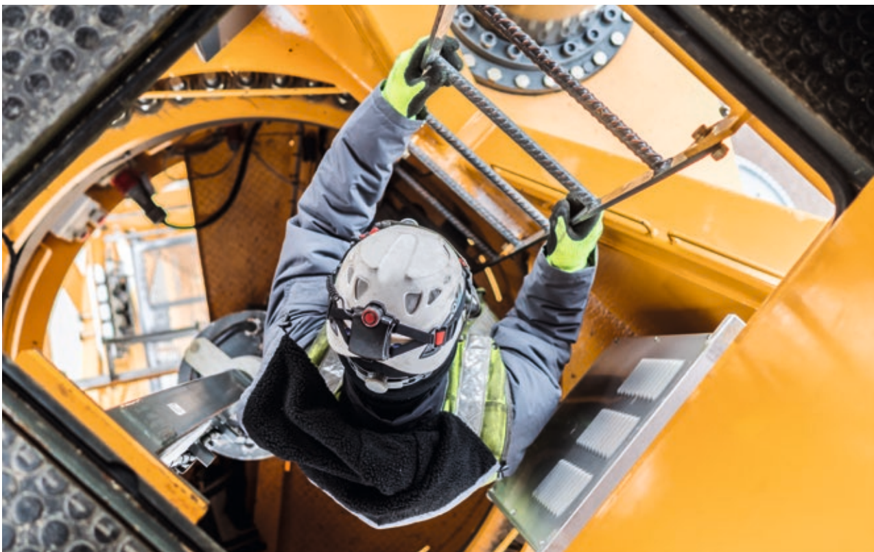
Ein Kundendiensteeinsatz an einem Turmdrehkran 630 EC-H an einer Windkraftanlage in Mallerstetten bei Nürnberg (Deutschland)
