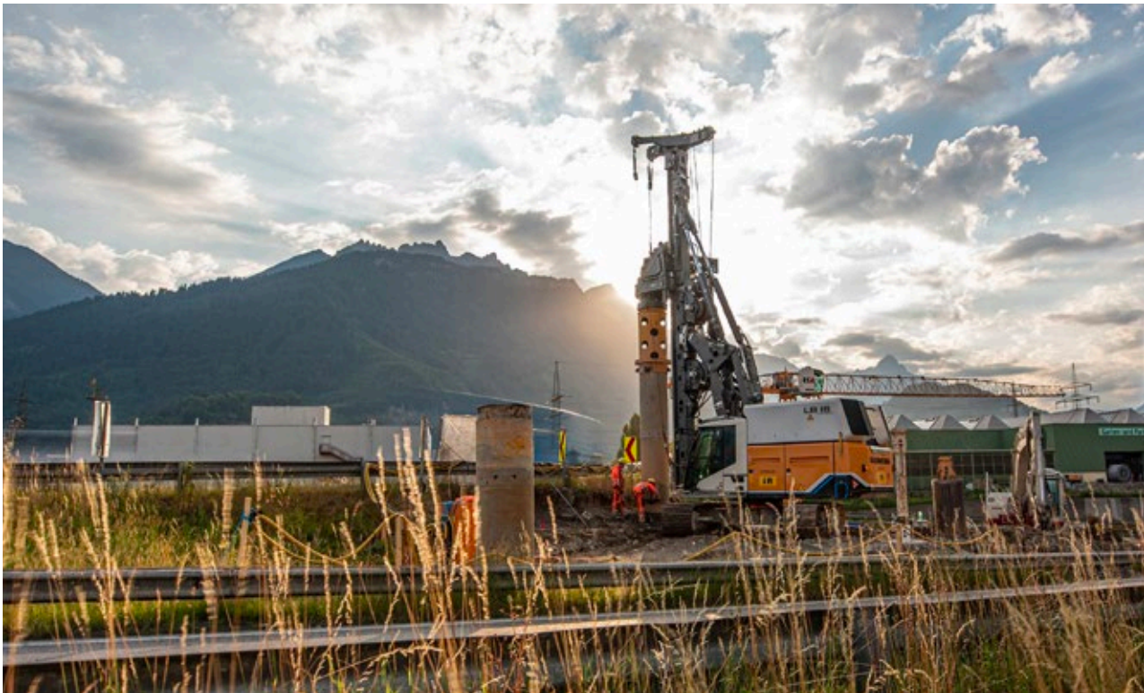
Das erste akkubetriebene Grossdrehbohrgerät der Welt, das LB 16 unplugged, wird auf einer der grössten Strassenbaustellen in Westösterreich eingesetzt
