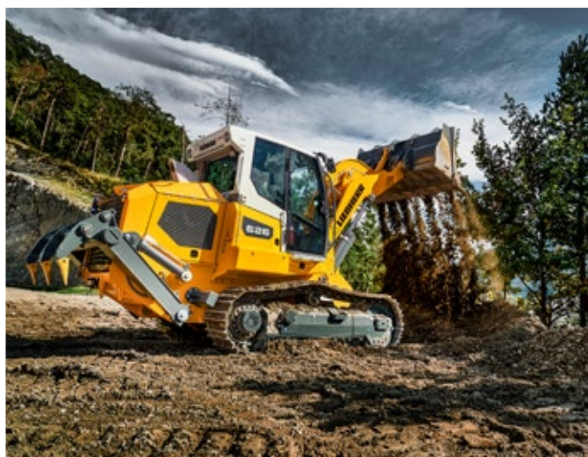
Ładowarka gąsienicowa LR 626 G8.0 podczas prac zbrojenia terenu
