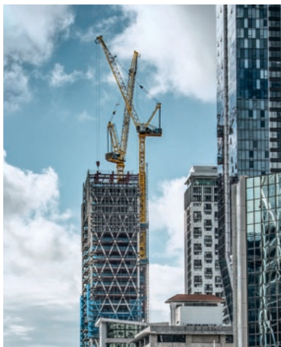
Żuraw wieżowy HC-L przy budowie wieżowca Seascape w Auckland (Nowa Zelandia)
