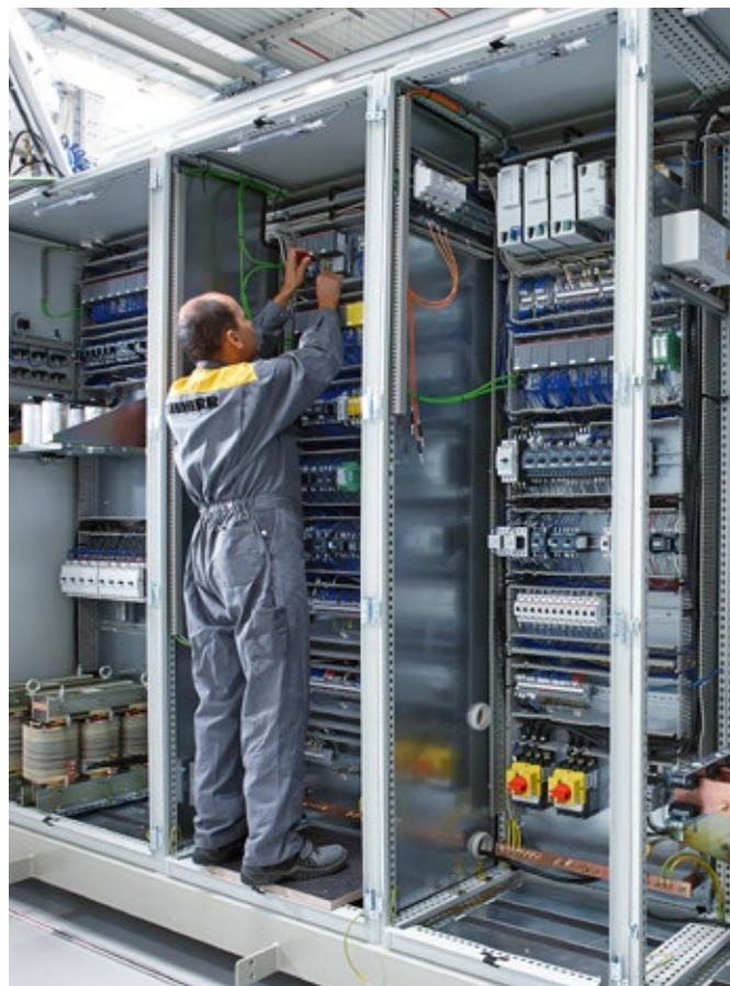
Instalowanie rozdzielni dla dźwigów kontenerowych
