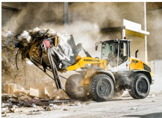
L 514 przy pracach recyklingowych
