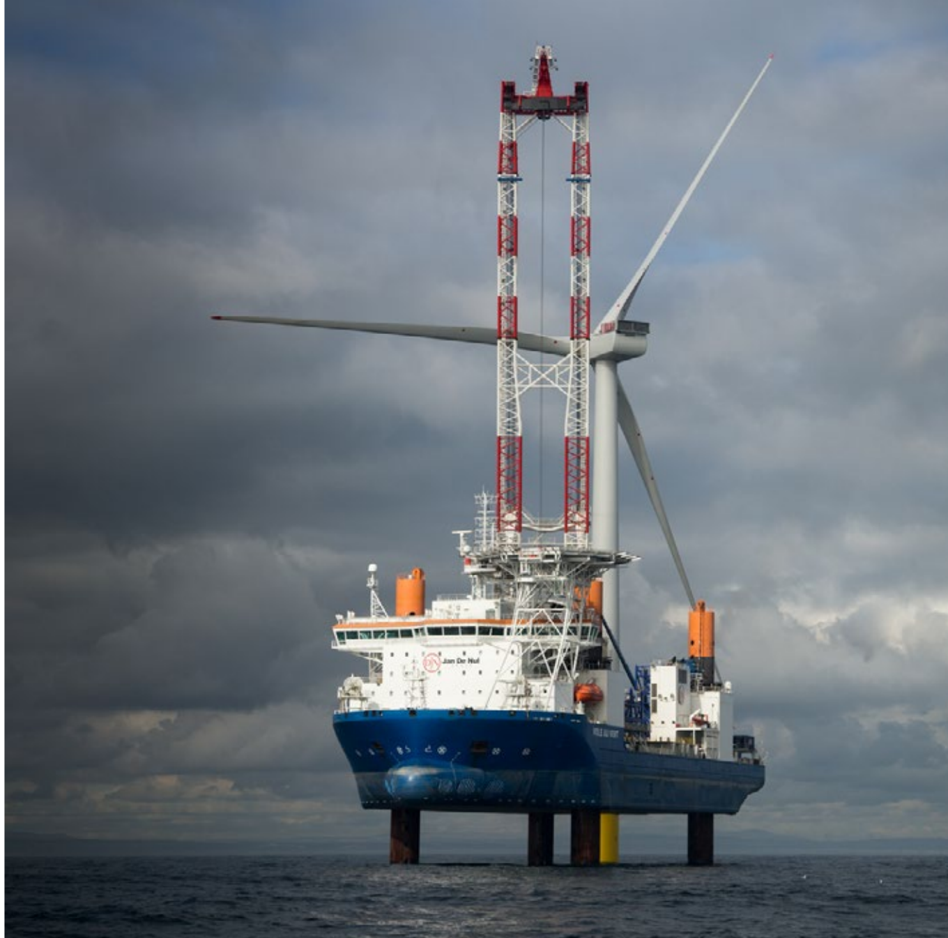
Żuraw morski CAL 45000, zaprojektowany jako „crane around the leg”, podczas pracy na pokładzie „Vole au Vent” – może unieść do 1200 ton.
