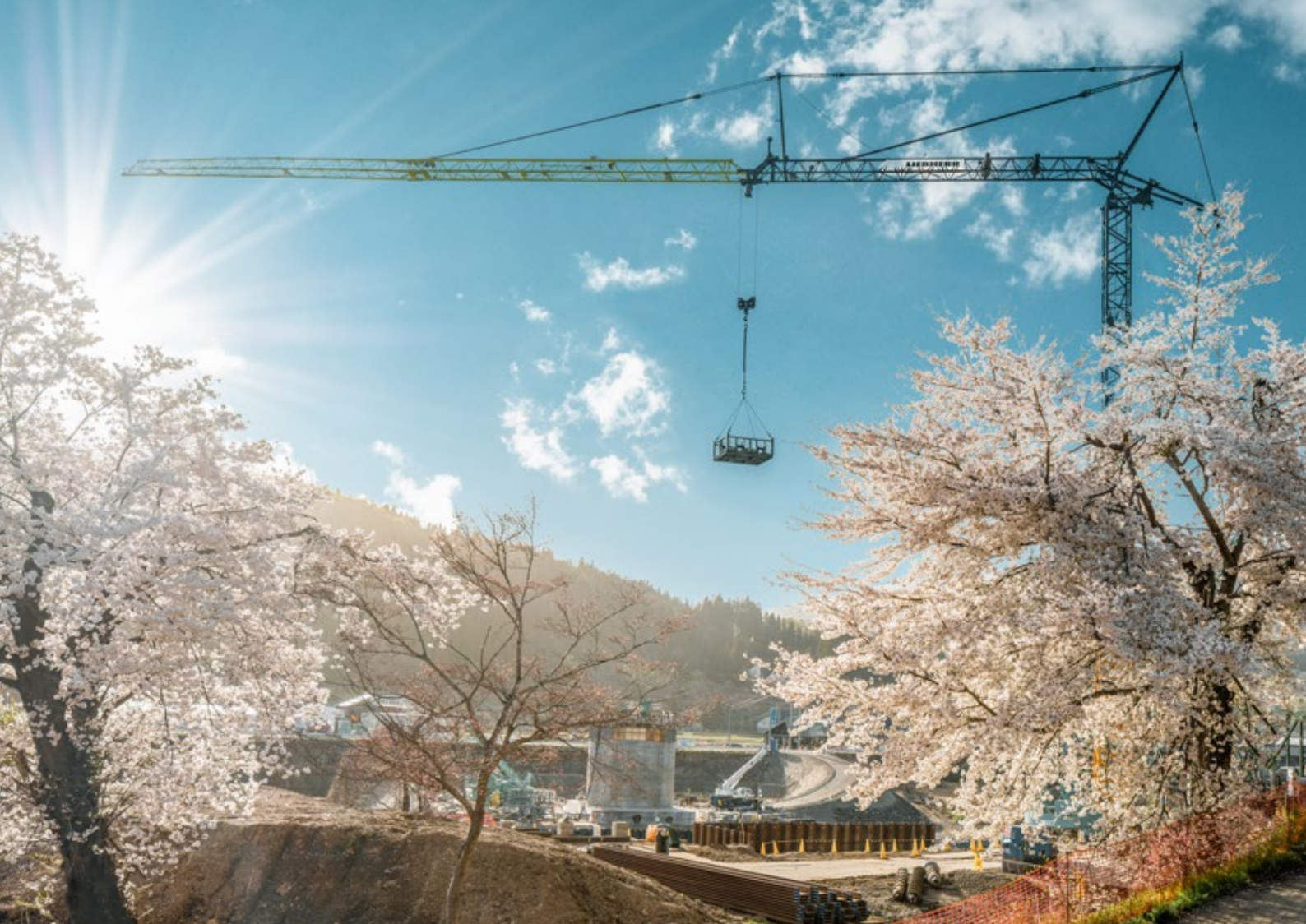
Żuraw szybkomontowalny 53 K przy budowie mostu YURII w Nagano (Japonia)
