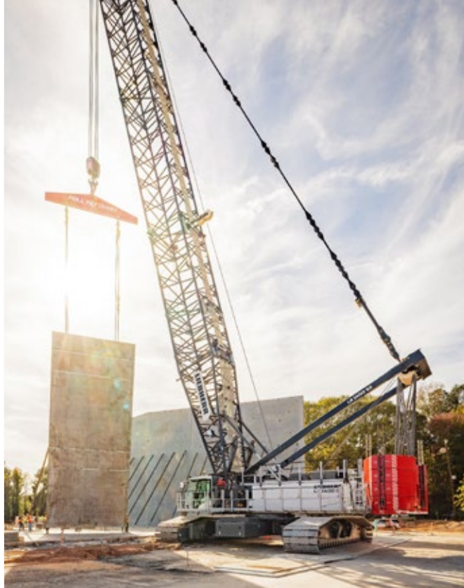
Żuraw gąsienicowy LR 1400 SX podnoszący ogromne płyty betonowe w Atlancie (USA)
