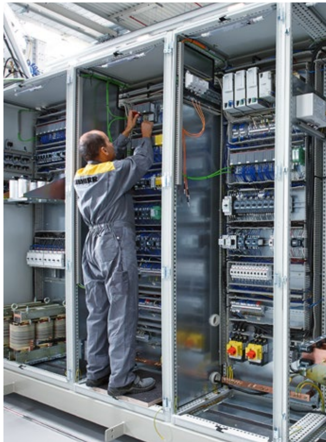
Instalarea unităților de comandă la macaralele pentru containere
