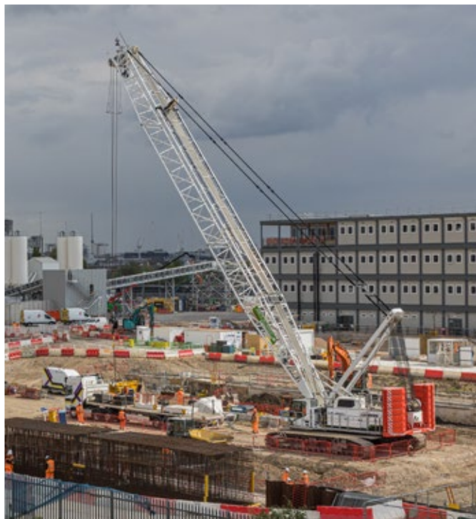
LR 1250.1 pe acumulator unplugged în timpul lucrărilor de ridicare în Londra (Marea Britanie)
