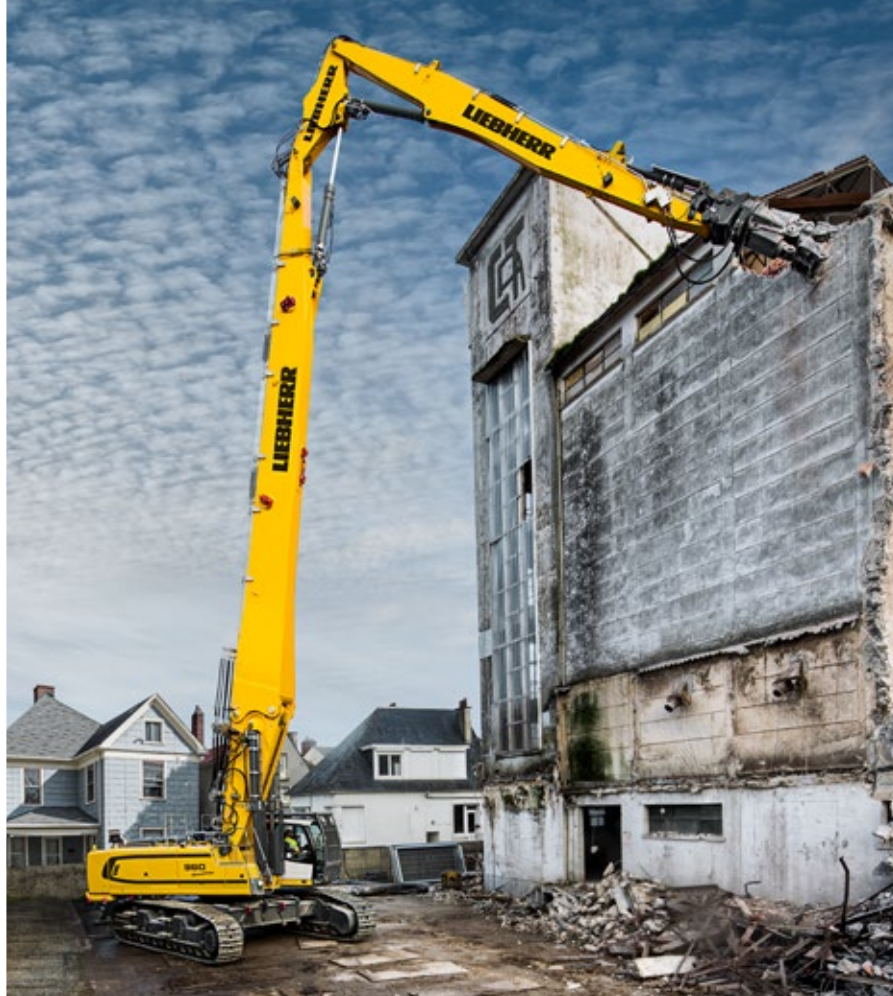
Excavatorul pe șenile R 960 utilizat pentru demolarea unui siloz în Frévent (Franța)
