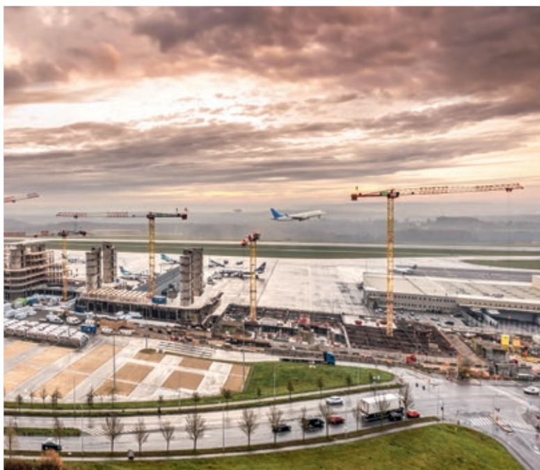
Macarale EC-B la lucru la construcția centrului de afaceri Skypark din Luxemburg
