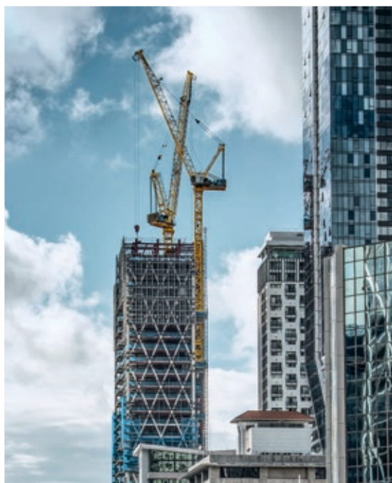
Macarale turn HC-L la lucru la construcția blocului turn Seascape din Auckland (Noua Zeelandă)
