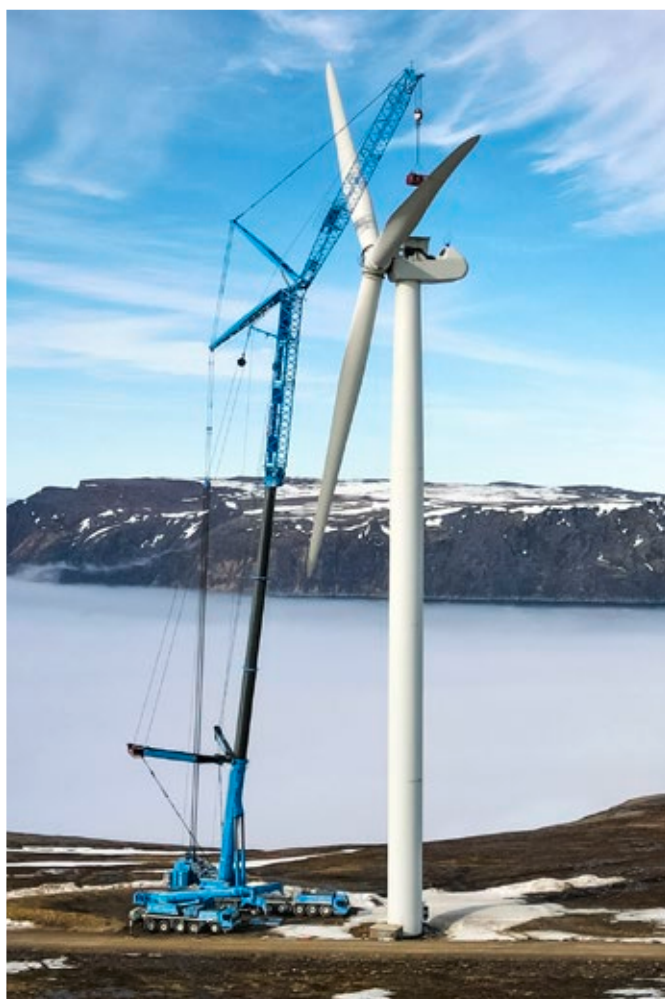
LTM 1750-9.1 – prevăzut cu ancorare în Y, prelungire telescopică a brațului și braț cu zăbrele – amplasează o turbină eoliană în Norvegia.
