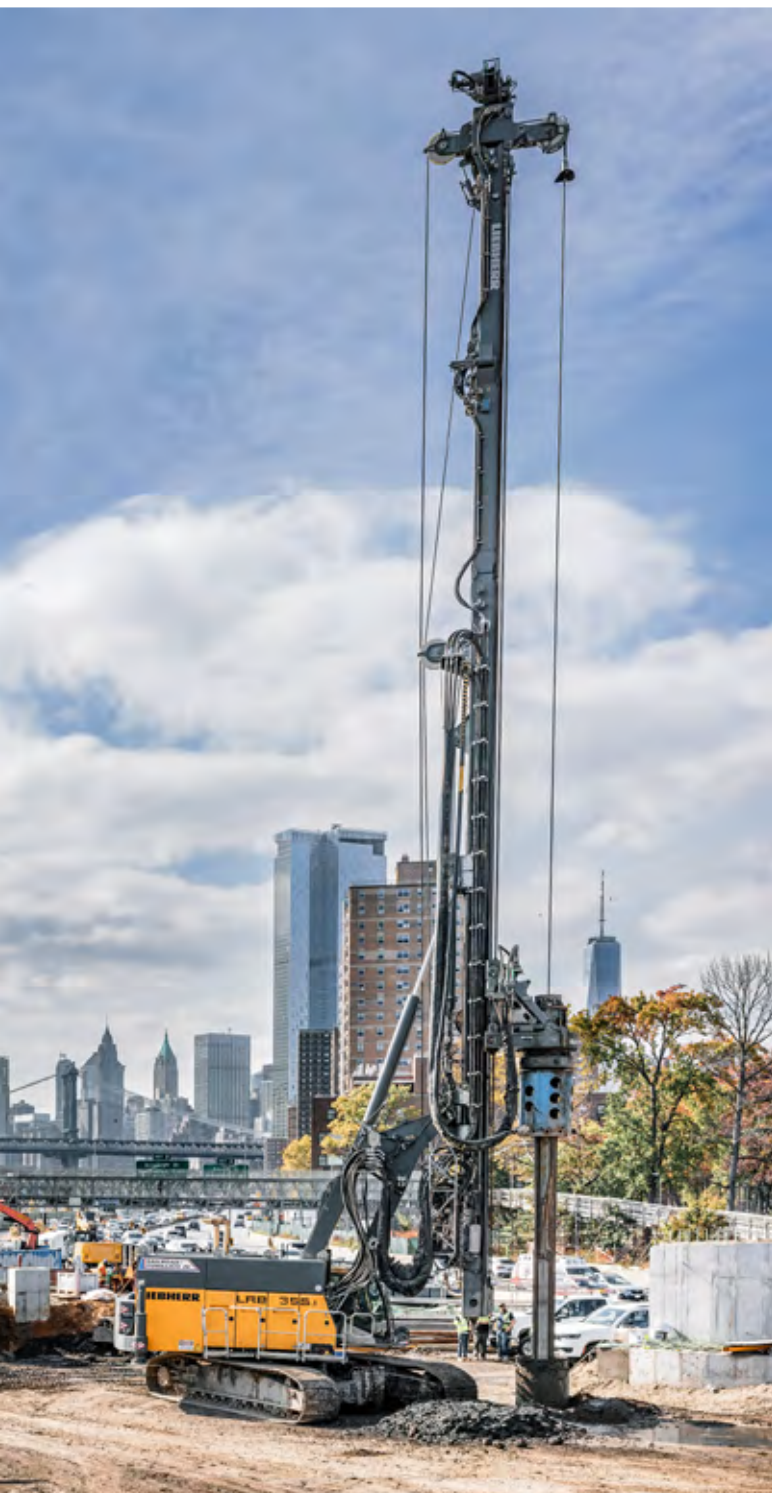
LRB 355.1 打桩机和钻机在纽约曼哈顿(美国)进行钻探
