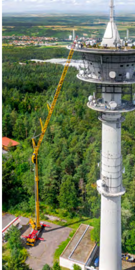
摇杆模式下的 MK 140 正在更换一座通信塔的天线
