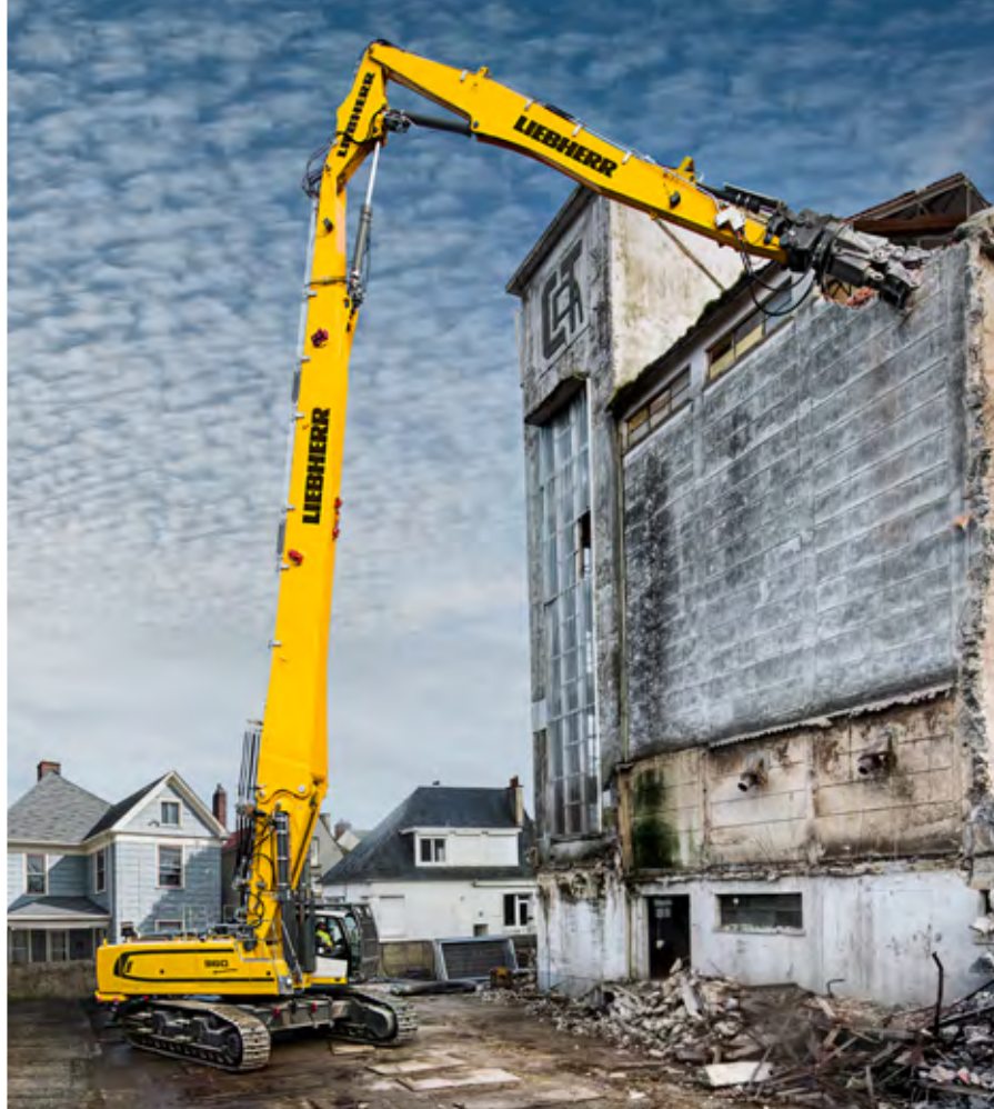
R 960 履带式挖掘机在 Frévent (法国) 用于拆除谷仓
