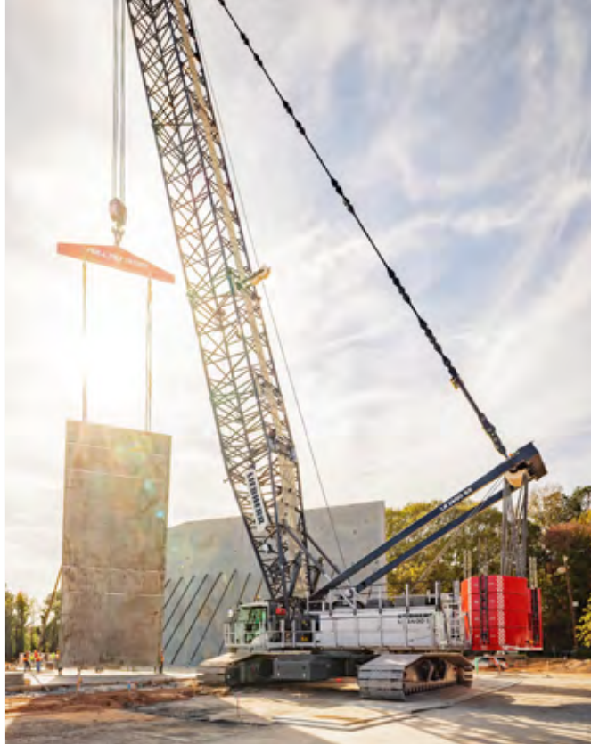
LR 1400 SX 履带式起重机在亚特兰大 (美国) 吊起大型混凝土板
