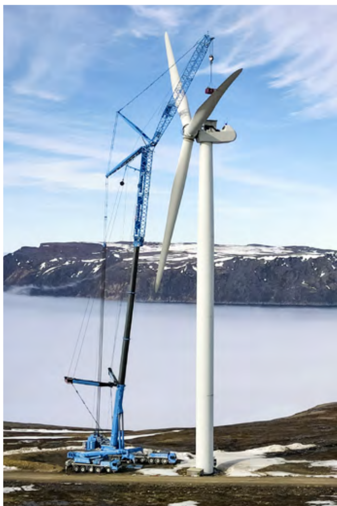
带 Y 型拉线、加长伸缩臂和旋转臂的 LTM 1750-9.1 在挪威安装风力涡轮机。
