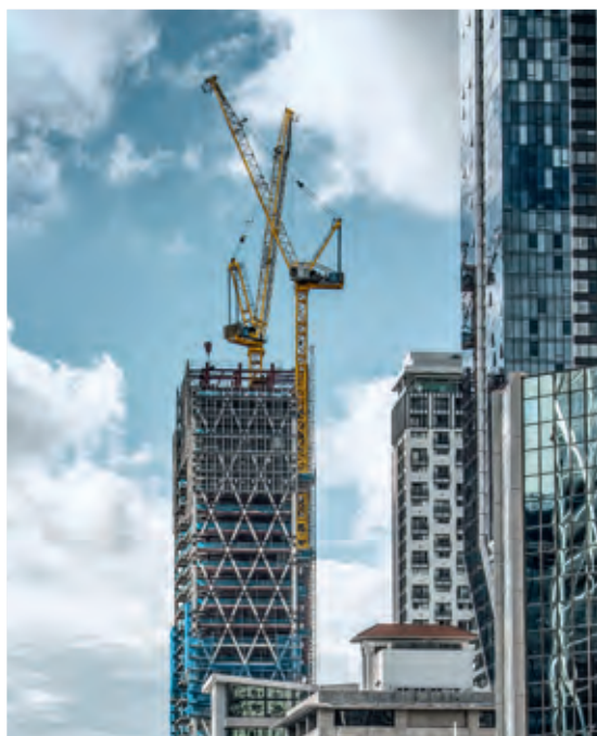
HC-L 塔式起重机在奥克兰 (新西兰) 的 Seascap 摩天大楼施工
