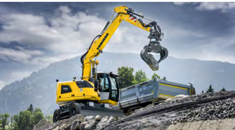
A 914 Compact Litronic 在 Oberallgäu (德国) 的一个道路施工现场作业
