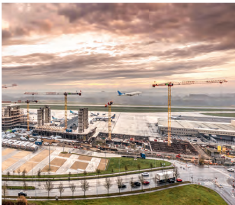
EC-B 起重机在卢森堡 Skypark 商业中心施工
