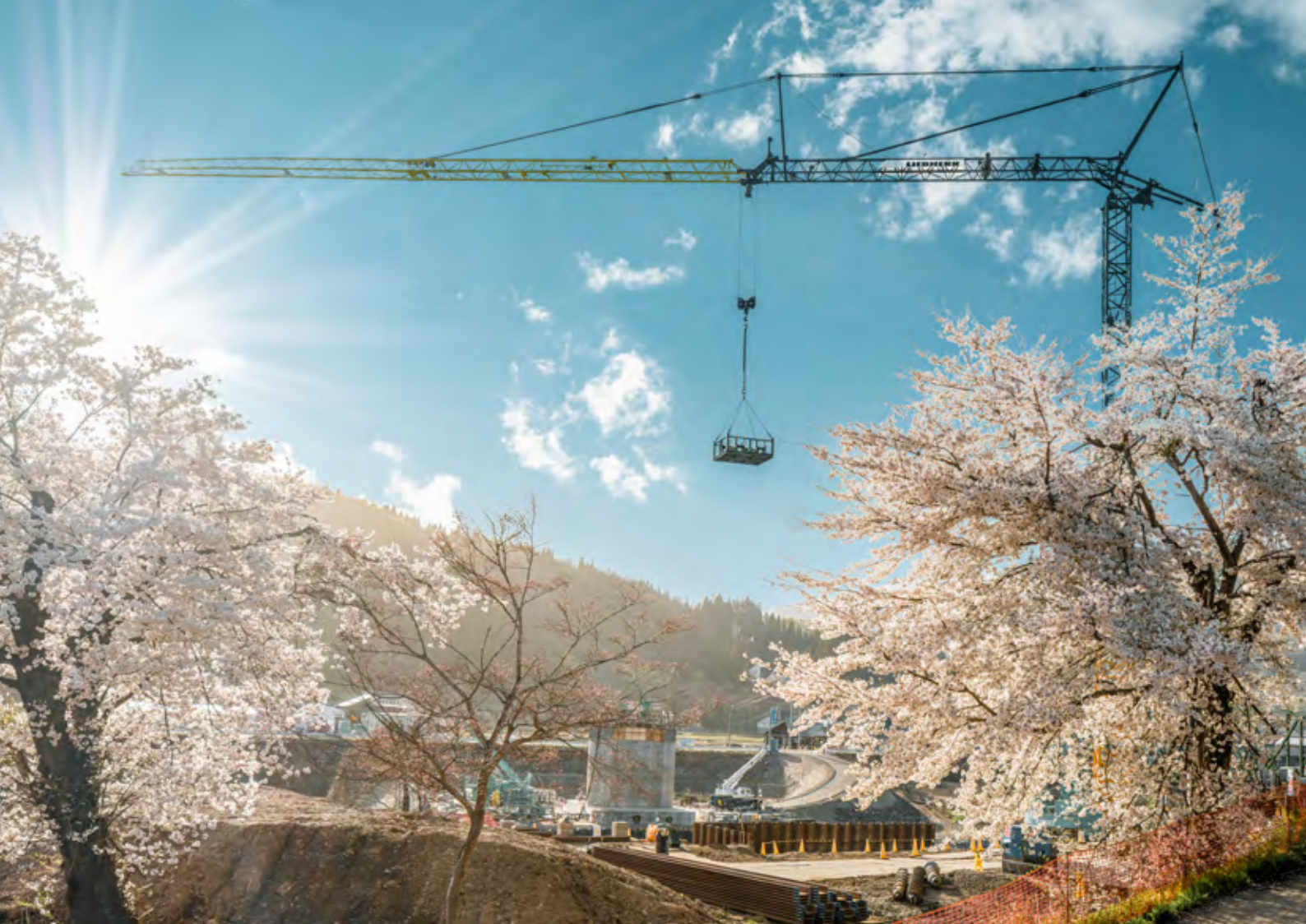
53 K 快速架设起重机在长野 (日本) 的 YURII 大桥施工
