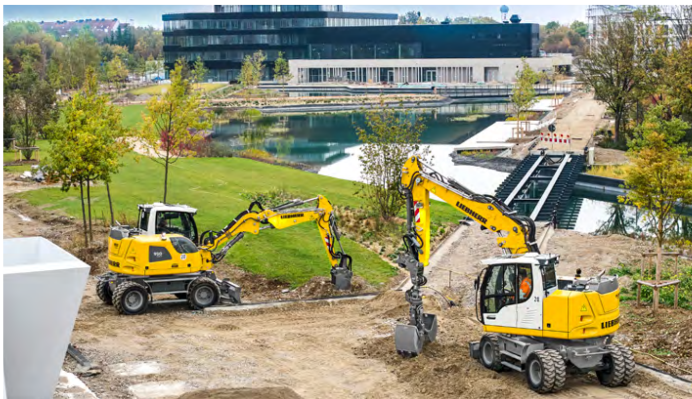
A 910 Compact Litronic 和 A 913 Compact Litronic 在慕尼黑 (德国) 附近的一个景观施工项目现场进行作业
