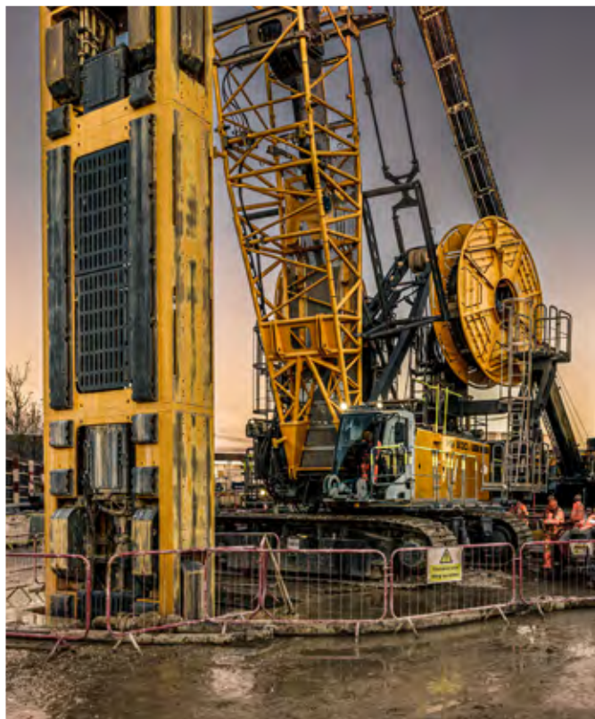
配有连续墙开槽机的 HS 8130 在伦敦 (英国) 开展作业
