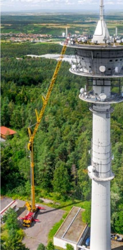
La MK 140 en mode de relevage lors du remplacement d'antennes d'une tour de télécommunications
