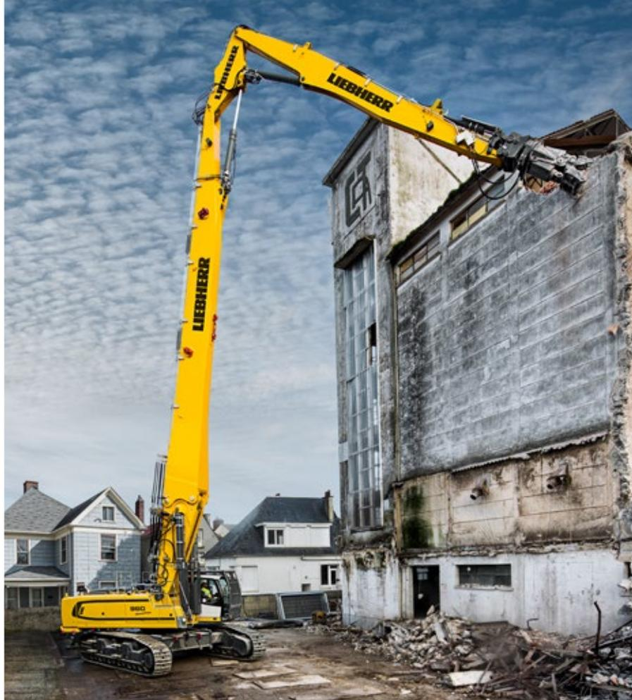
La pelle sur chenilles R 960 sur le chantier de déconstruction sélective d'un silo à Frévent (France)
