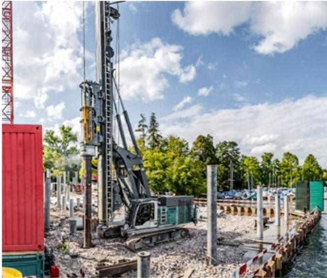
La LRB 355 lors du battage de pieux tubulaires en béton avec le marteau hydraulique H 15-10 au lac de Zurich (Suisse)
