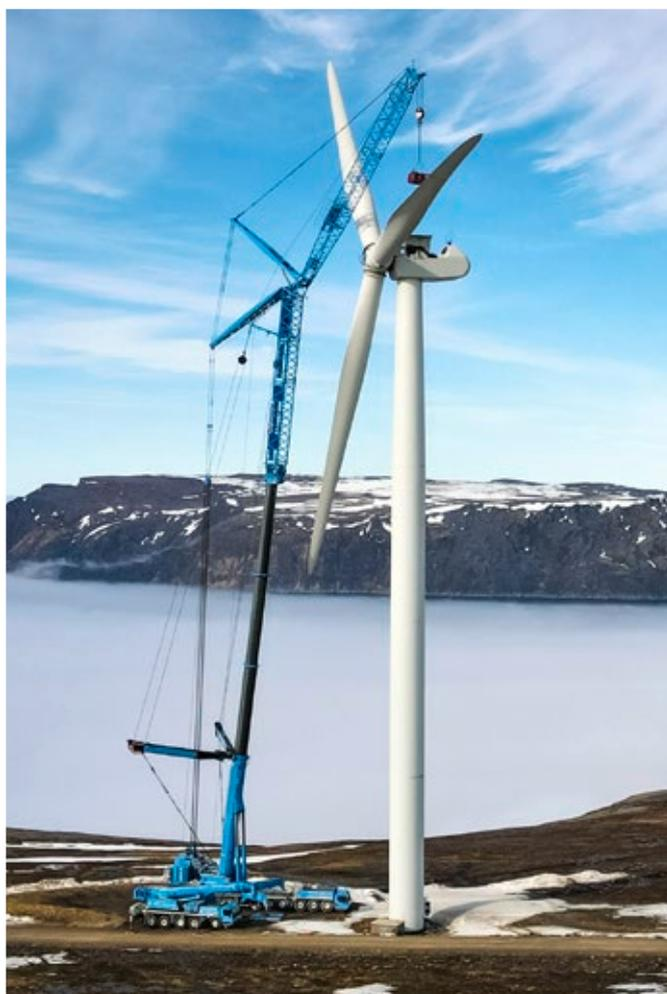
La LTM 1750-9.1 équipée d'un haubanage en Y, d'une rallonge de flèche télescopique et d'une flèche à treillis à volée variable monte une éolienne en Norvège.
