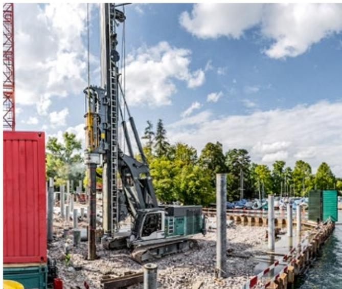
O LRB 355 cravando estacas centrifugadas com o martelo hidráulico H 15-10 no Lago de Zurique (Suíça)
