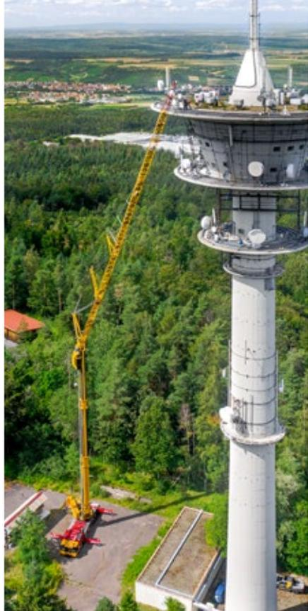
Guindaste MK 140 operando no modo basculante em substituição de antena de torre de telecomunicação
