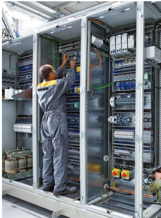
Instalace řídicích jednotek pro kontejnerové jeřáby
