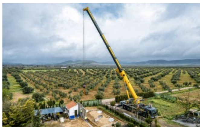
Sestavování hotových betonových dílů na rozsáhlé olivové plantáži – průkopnický řídicí systém LICCON3 pro ovládání jeřábu vstupuje do sériové výroby s LTM 1110-5.2.
