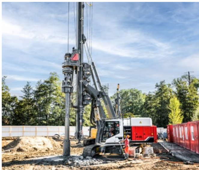
LB 25 unplugged demonstrující své schopnosti v oblasti vrtání nosné konstrukce v Curychu (Švýcarsko)
