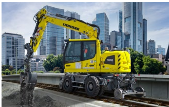
LA 922 Rail durante i lavori di sterro su una linea ferroviaria a Francoforte sul Meno (Germania)
