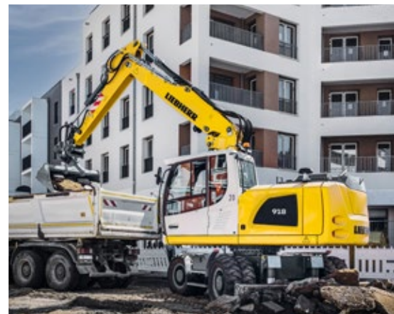
L'A 918 Litronic impiegato nei lavori di movimento terra a Ratisbona (Germania)
