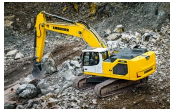
L'escavatore cingolato R 938 utilizzato in una cava di pietra Metzeral (Francia)
