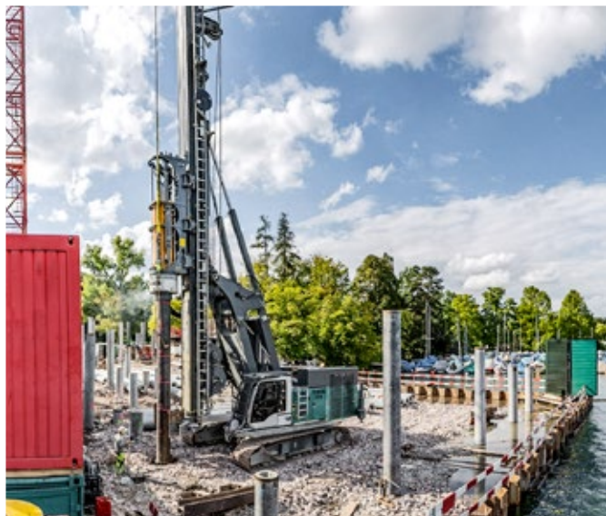
Un LRB 355 infila dei pali per tubi di cemento con il martello idraulico H 15-10 sul lago di Zurigo (Svizzera)
