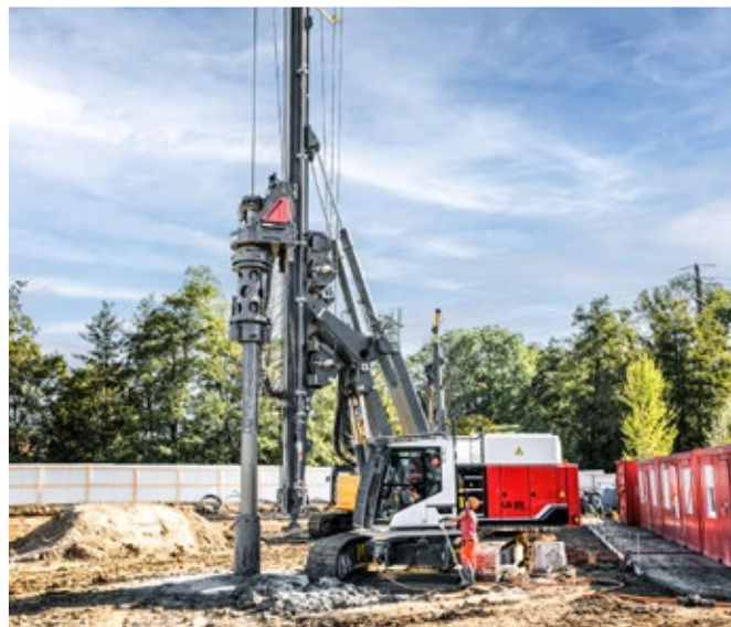
A Zurigo (Svizzera), la LB 25 unplugged mette in mostra le sue abilità nella perforazione Kelly.
