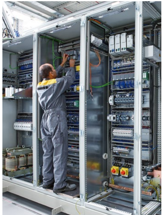
Installazione di armadi elettrici di gru per container
