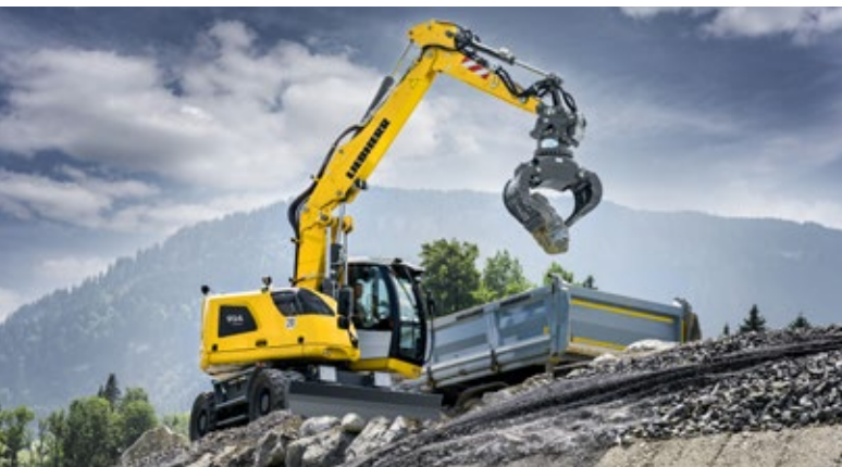
LA 914 Compact Litronic durante lavori di costruzione stradale a Oberallgäu (Germania)
