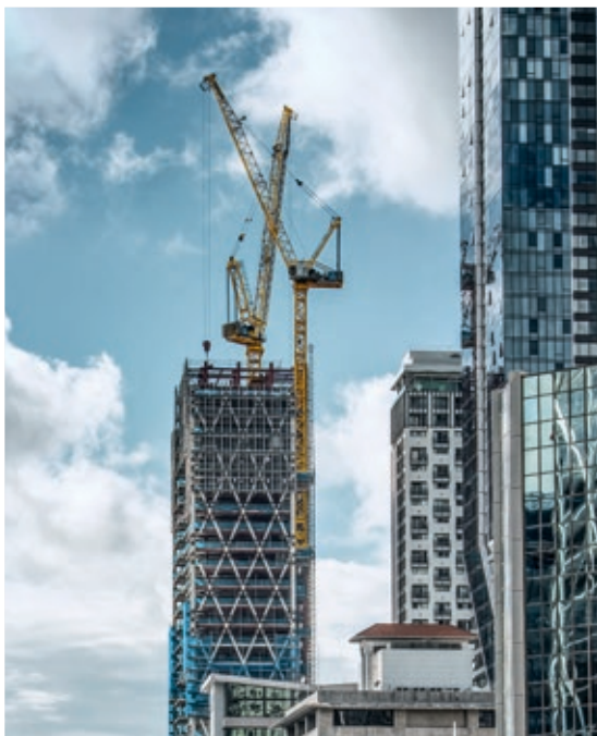
Una gru a torre HC-L durante la costruzione del grattacielo Seascape ad Auckland (Nuova Zelanda)
