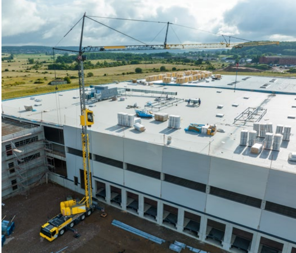
Grazie al loro concept speciale, le gru MK sono mobili e dall'ingombro particolarmente ridotto. In questo modo, sono estremamente versatili – come ad esempio a Gießen (Germania).
