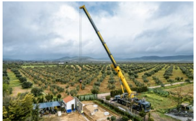
Montaggio di elementi prefabbricati in calcestruzzo in un ampio oliveto: con l'LTM 1110-5.2, il sistema di comando della gru all'avanguardia LICCON3 diventa di serie.
