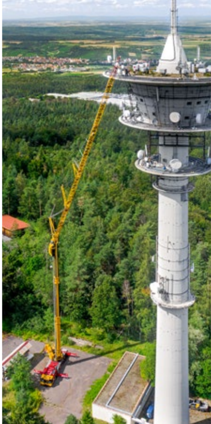
La MK 140 in modalità inclinata durante la sostituzione di apparecchiature tecniche di una torre di telecomunicazioni
