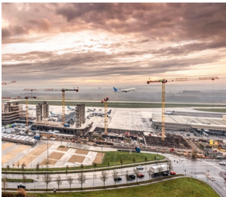
EC-B daruk a Skypark Business Center építésénél Luxemburgban
