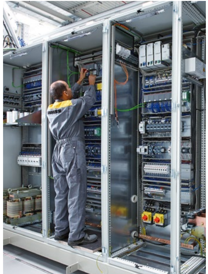
Vezérlőszekrény felszerelése konténerdarukra
