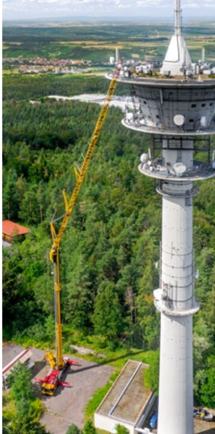
Az MK 140 összecsuított állapotban egy távközlési torony antennatechnikájának cseréje közben
