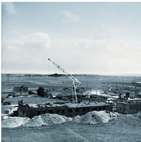
Die Montage des TK 10 dauerte zwei bis drei Stunden, im Gegensatz zu den bis dahin üblichen Kranen, deren Aufbau mehrere Tage dauerte.
