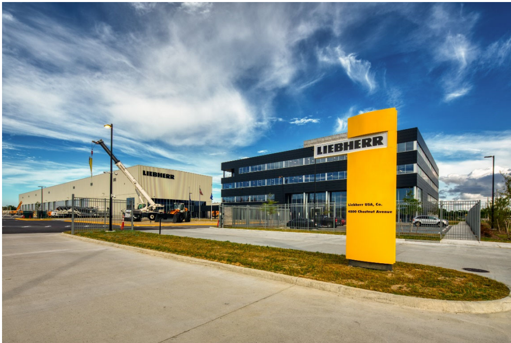
Exterior_Frontage_Liebherr_US_Newport_News_04_RedDoor_Print (300 dpi) Liebherr USA, Co. Newport News
