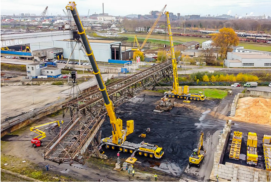
liebherr-bracht-ltm1450-8-1-duisburg01.jpg 30 Tonnen der 80 Jahre alten Kranbahn wurden mit Schweißbrennern getrennt und von einem LTM 1450-8.1 abgelegt.
