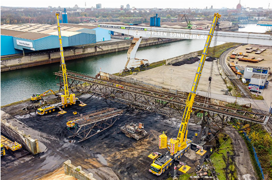
liebherr-bracht-ltm1450-8-1-duisburg02.jpg 200 Tonnen an den Haken der beiden LTM 1450-8.1 von Bracht aus Duisburg und Recklinghausen.
