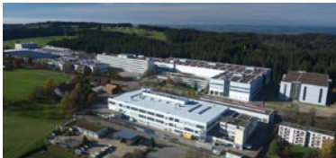
Liebherr-Aerospace Lindenberg GmbH, Lindenberg (Allemagne) - © Liebherr
