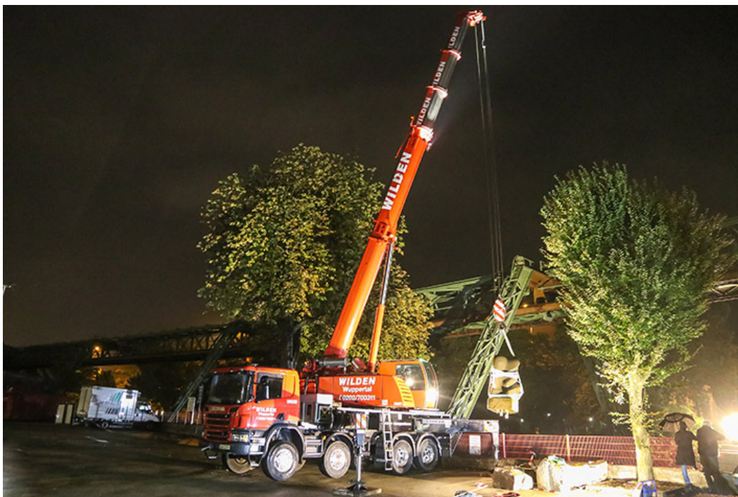
liebherr-ltf1045-4.1-wilden-tuffi3.jpg Am Haken: Der LTF 1045-4.1 hebt den sanften Riesen zurück in die Wupper.
