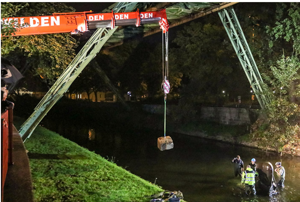
liebherr-ltf1045-4.1-wilden-tuffi5.jpg Besser geschützt: Bruchsteine mindern künftig den Wasserdruck auf die Elefanten-Dame.
