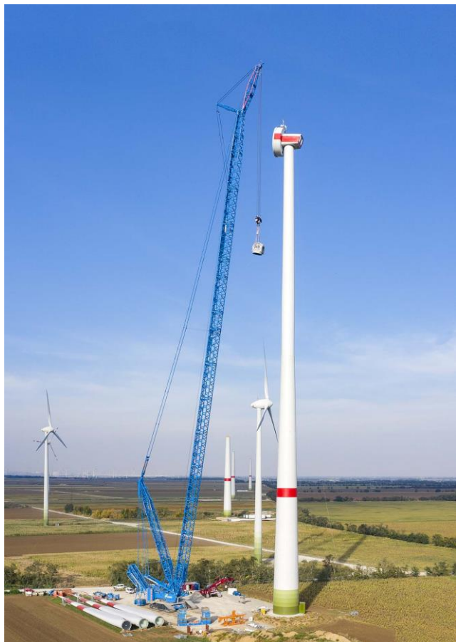
liebherr-lr11000-felbermayr-02.jpg Установка колпака ротора на высоте 160 метров. На очереди лопасти.
