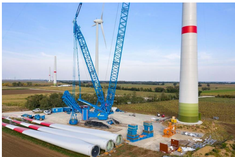
liebherr-lr11000-felbermayr-03.jpg Компактный, современный и мощный – кран LR 11000 оснащён системой «VarioTray» и гидравлически регулируемой V-образной складывающейся рамой, которые значительно упрощают работу крановщиков.
