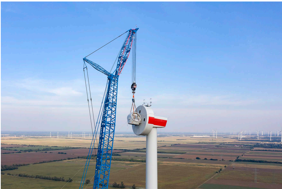
liebherr-lr11000-felbermayr-04.jpg Durchdacht: Die 15 Meter lange Gitterspitze am 168 Meter langen Ausleger ermöglicht ein sicheres Hantieren mit den oberen Bauteilen der Windenergieanlage bei der Montage. Unser Bild zeigt den Einbau der Nabe.
