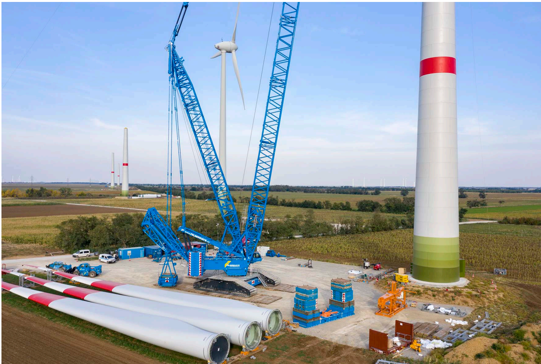
liebherr-lr11000-felbermayr-03.jpg Kompakt, modern, stark: Der neue LR 11000 von Felbermayr ist mit allen innovativen Features ausgestattet. VarioTray und V-Frame sparen der Kranmannschaft viel Zeit beim Arbeiten.
