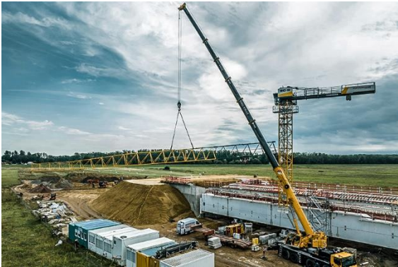
liebherr-125-ec-b-wittenberge-hueffermann-04.jpg Montage des 125 EC-B 6 mit Hilfe eines Liebherr-Mobilkrans.
