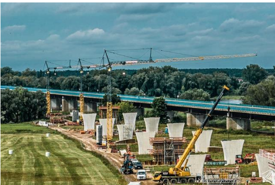
liebherr-125-ec-b-wittenberge-hueffermann-06.jpg Neben dem fest an der Brücke montierten Turmdrehkran stehen noch drei Liebherr-Schnelleinsatzkrane 81 K.1 auf der Baustelle. Die Arbeiten an den Brückenpfeilern schreiten voran, Anfang 2024 sollen die ersten Brückenteile über die Elbe geschoben werden.
