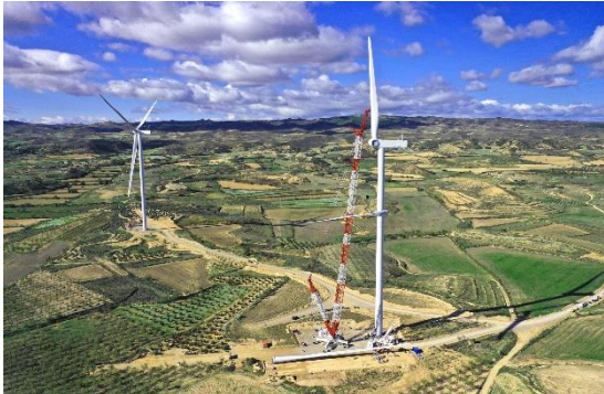
Liebherr_LR 1700-1.0W _ Grupo Aguado_Cascante
