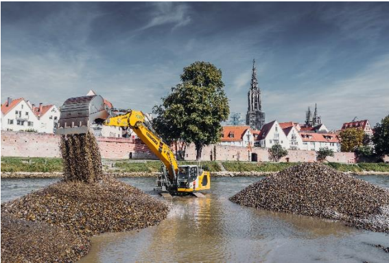
liebherr-pelle sur chenilles-intervention-sur-le-danube-2.jpg
