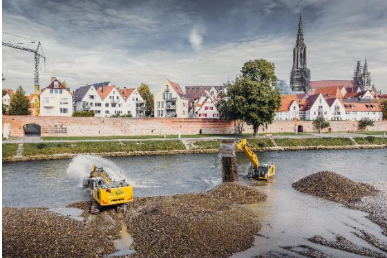
liebherr-pelle sur chenilles-intervention-danube-1.jpg
