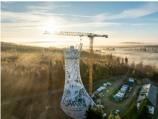
liebherr-340-ec-b-16-hexenbesen-01.jpg Der Liebherr 340 EC-B 16 beim Heben der Stahlbauteile.
