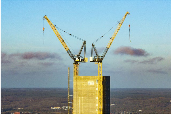
liebherr-nkt-tower3-karlskrona-01.jpg Las grúas 542 HC-L y 258 HC-L de Liebherr.
