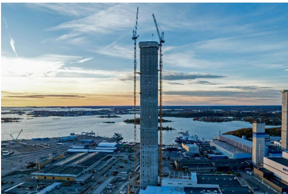
liebherr-nkt-tower3-karlskrona-03.jpg Gracias a una innovadora solución de grúa, la torre se construyó en tan solo 90 días.
