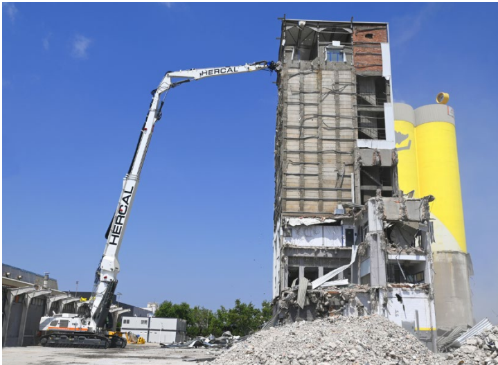
Hercal invierte en la excavadora de demolición más grande de la Península Ibérica, la Liebherr R 980 Demolition
