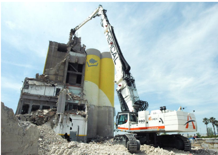
La excavadora Liebherr R 980 Demolition de Hercal se estrenará con la demolición de un edificio de hormigón armado en Barcelona, formado por 18 silos circulares y 2 silos cuadrados de 37,5 metros de altura.
