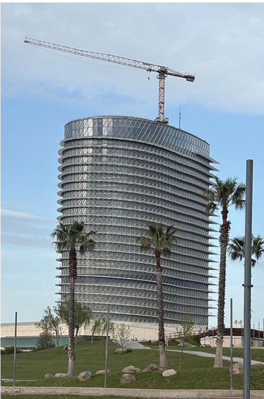
liebherr-110 EC-B-Grúas Cerezo_Torre del Agua.jpg
