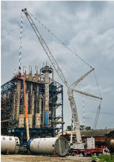
liebherr-orimom-ltm-1400-7.1.jpg LTM 1400-7.1, da Orimom, em operação de montagem industrial.
