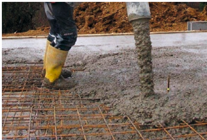
Parfaite répartition du béton grâce à une alimentation homogène sans à-coups en fin de tuyau.
