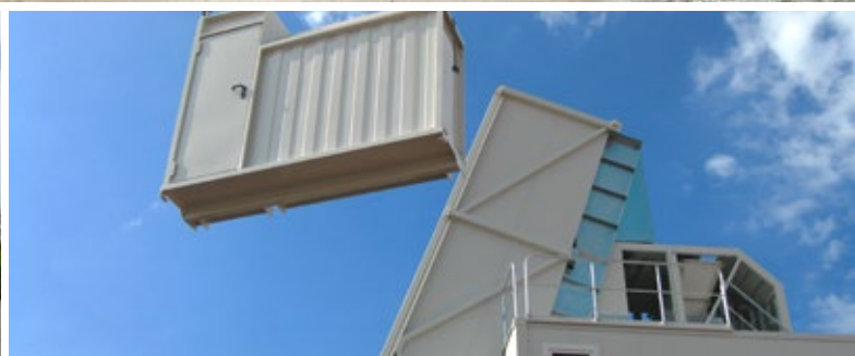
Монтаж Mobilmix 2.5 C
