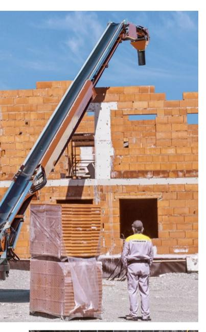
Le tapis Liebherr LTB se monte et se démonte en l'espace de quelques minutes. Cela a des effets positifs sur la rentabilité de l'appareil. Grâce à la construction fermée et aux éléments de capotage, la bande se nettoie aisément et rapidement.
