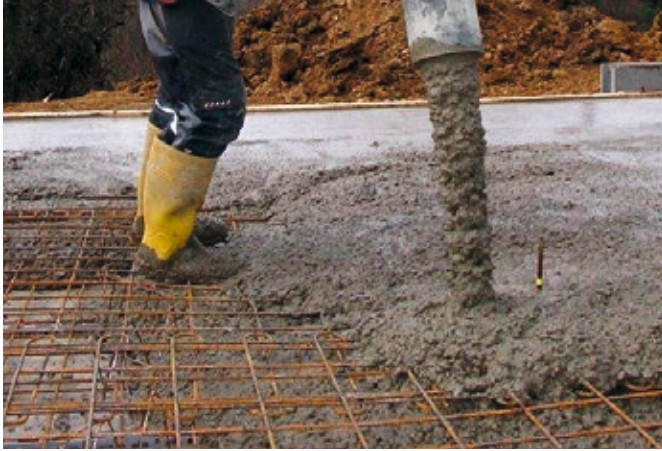
Perfekter Betoneinbau durch gleichmäßige Betonförderung ohne Ausschläge am Endschlauch.
