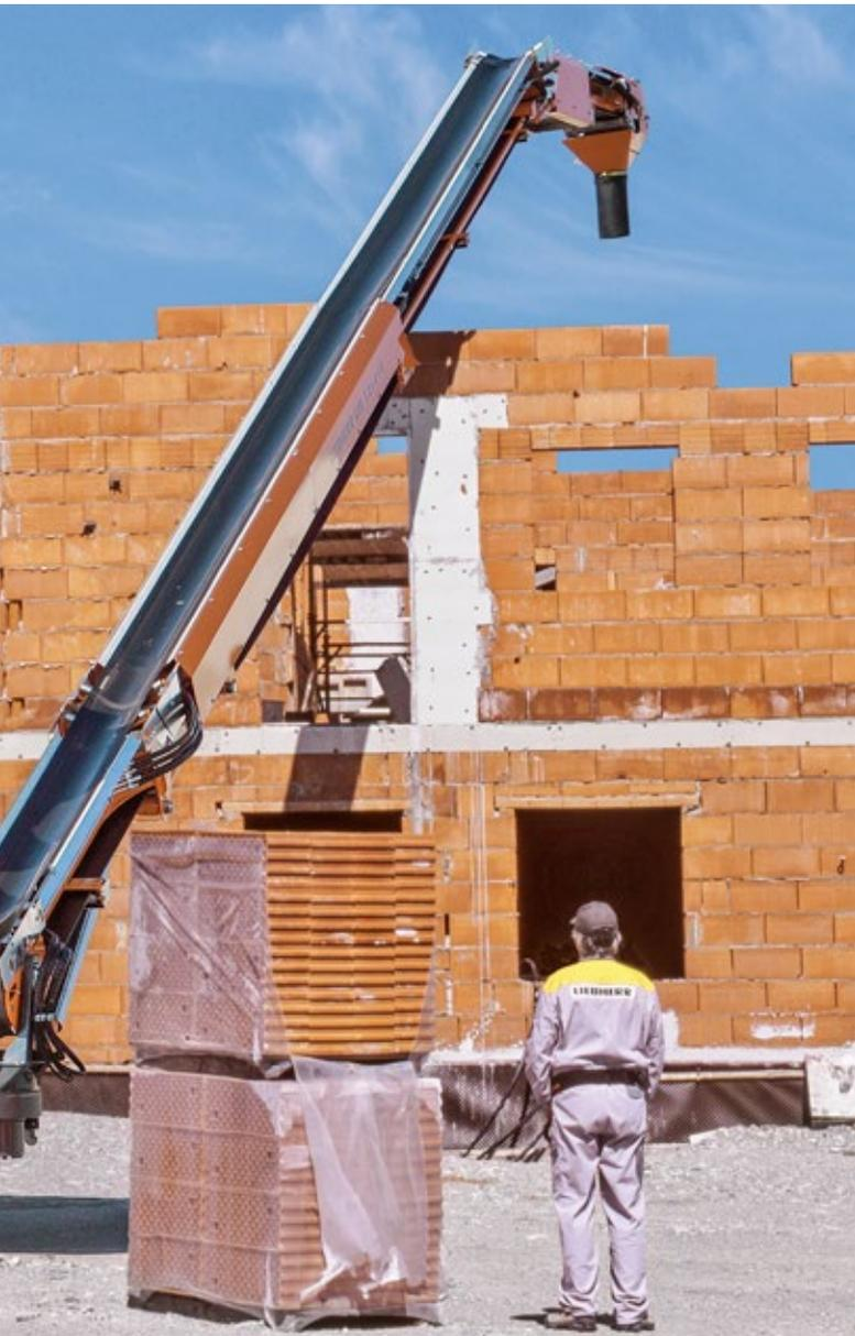
Das Liebherr-Förderband LTB ist in wenigen Minuten einsatzbereit. Dies wirkt sich positiv auf die Wirtschaftlichkeit aus. Durch die geschlossene Bauweise und die Verkleidungselemente ist das Band einfach und schnell zu reinigen.
