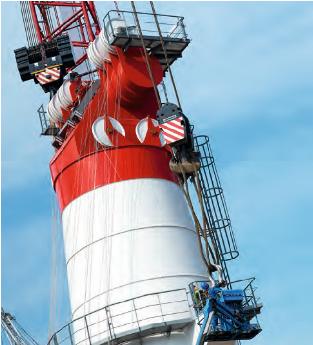
Echt heavy: Riesige Schakel und armdicke Stahlseile kommen beim Anschlagen des Mastoberteils zum Einsatz.
