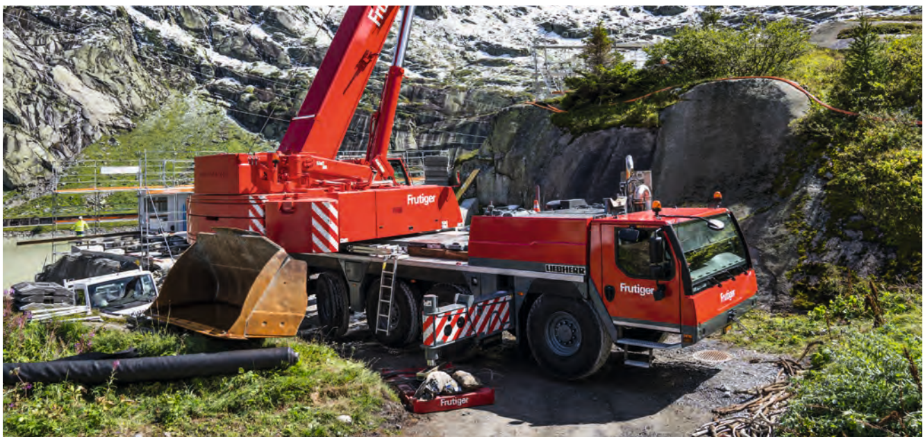
Die variable Abstützbasis VarioBase® machte den Kraneinsatz möglich.
