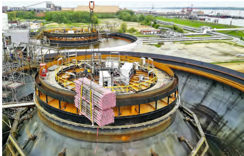
Innerhalb von vier Tages- und drei Nachtschichten hob der MK 140 insgesamt 125 Tonnen Gerüstmaterial ein.
