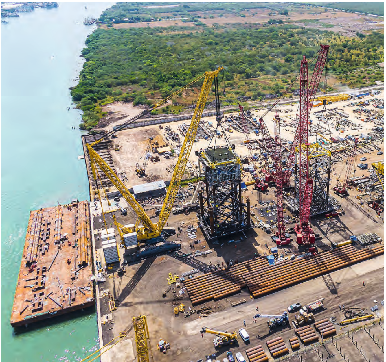
ESEASA fertigt aktuell sieben Ölplattformen für den staatlichen Mineralölkonzern PEMEX.
