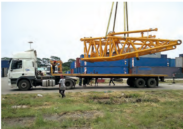
Verladung des Anlenkstücks des LR 11350 in Bangladesch
