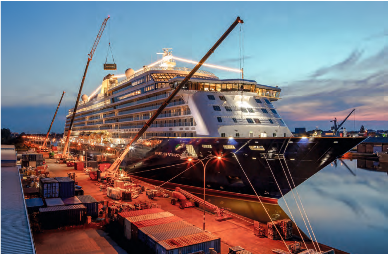
Parallel zu den Stellplätzen der Krane findet die Bestückungslogistik statt.
