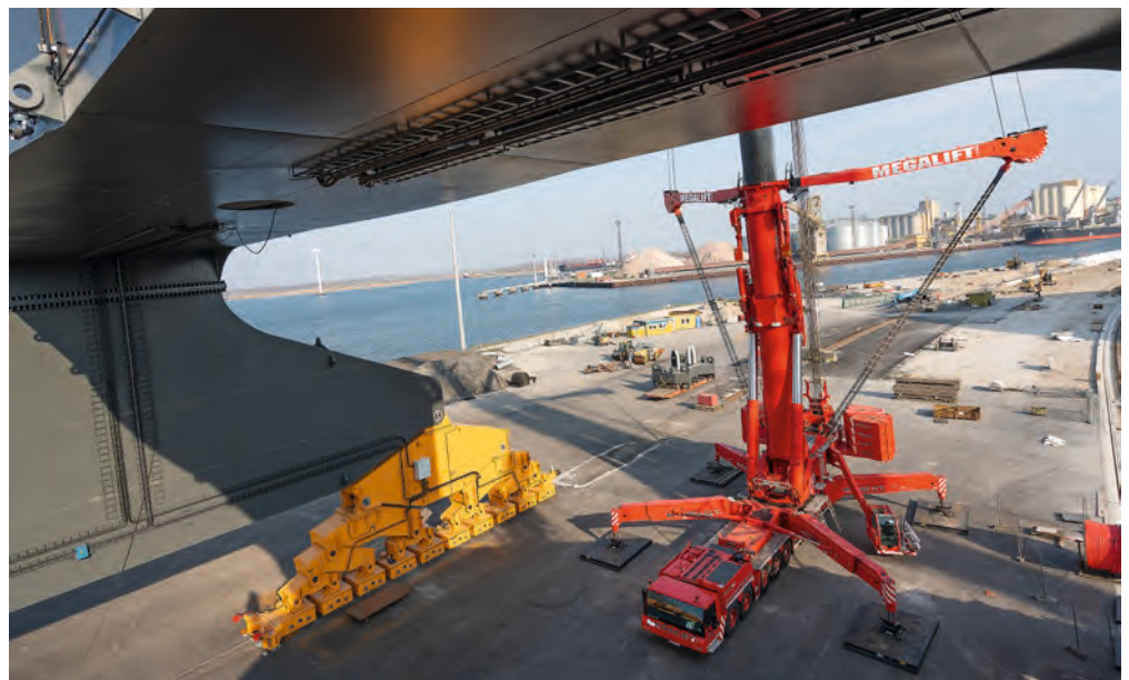
Geradezu filigran wirkt der Unterwagen des LTM 11200-9.1 vor dem machtigen, 30 Meter breiten Portal des Schwerlastkrans.
