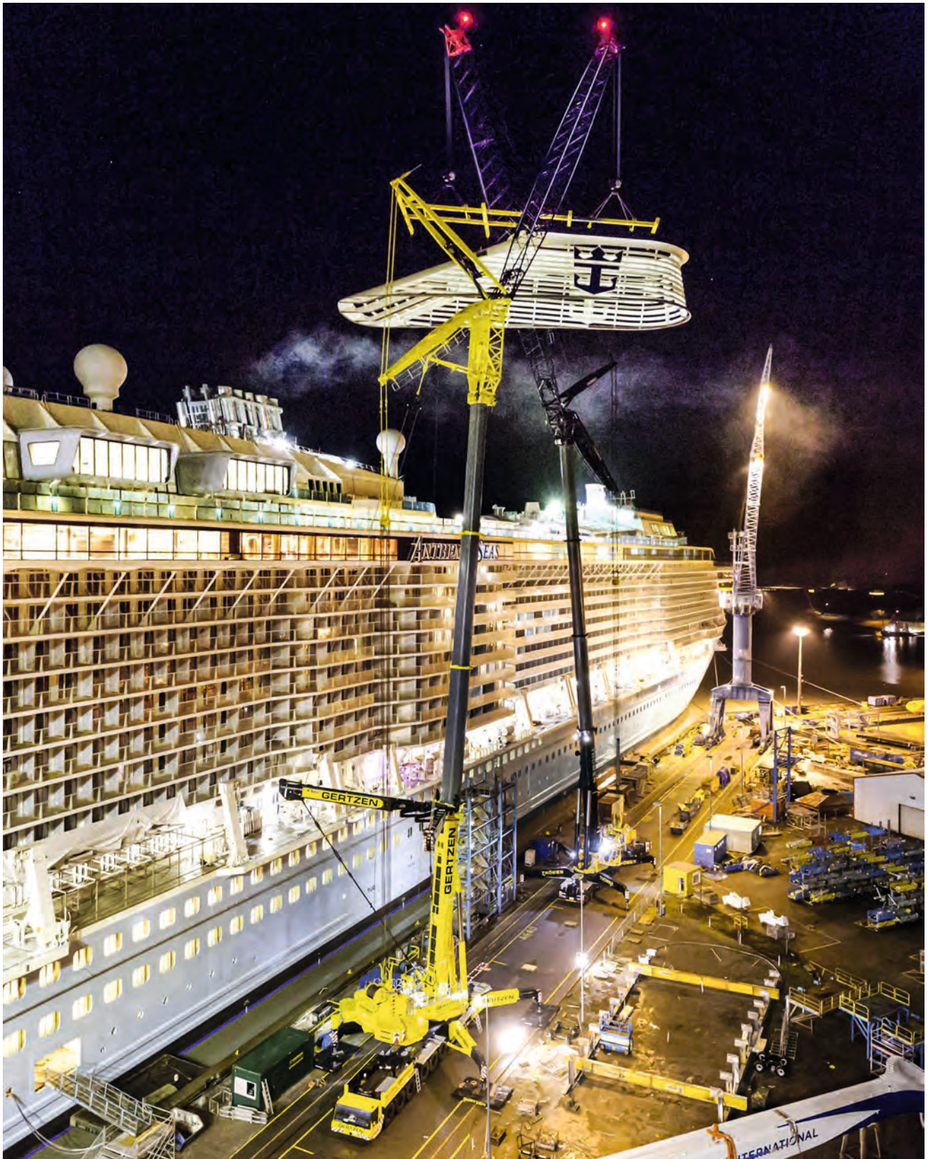
Fingerspitzengefühl bei Nacht: Behutsam fädeln die beiden Krane (Thömen und Gertzen) die Schlotverkleidung zwischen den Wippspitzen hindurch.
