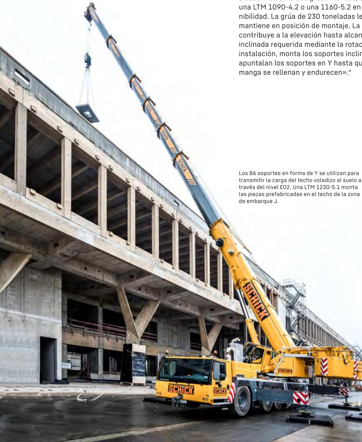
Los 86 soportes en forma de Y se utilizan para transmitir la carga del techo voladizo al suelo a través del nivel E02. Una LTM 1230-5.1 monta las piezas prefabricadas en el techo de la zona de embarque J.
