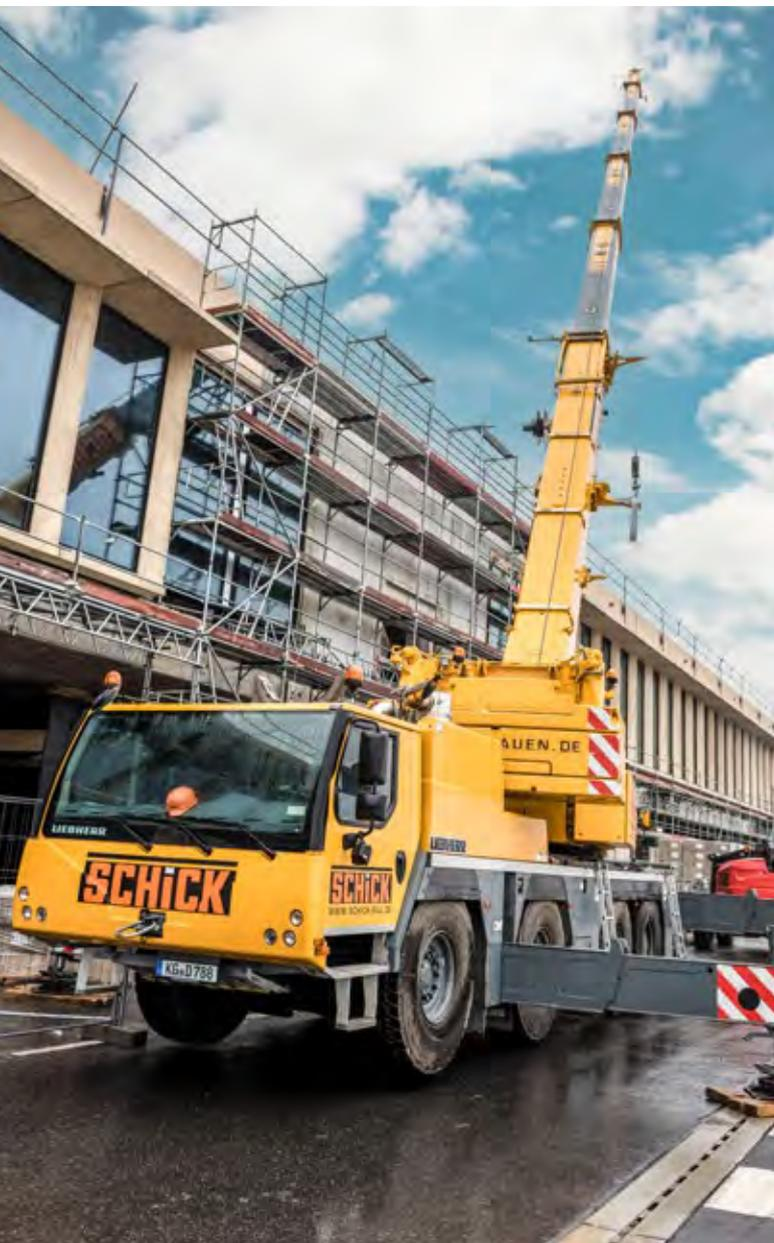
Una LTM 1090-4.2 monta elementos de fachada de hormigón de color en la zona de embarque H.
