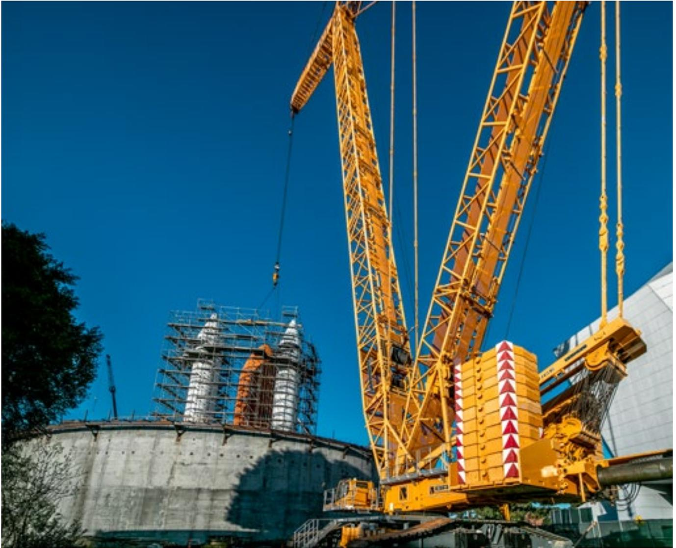
Mit einem Gegengewicht von 665 Tonnen, einer maximalen Ausladung von 46 Metern und 120 Metern Hubhöhe, positioniert der LR 1750/2 historische Komponenten an Ort und Stelle.
