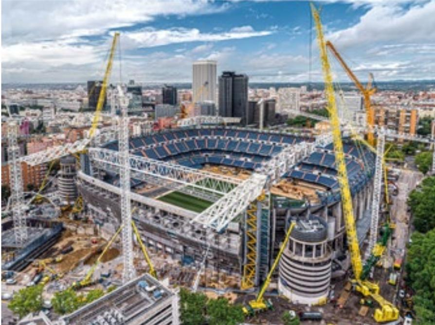
Insgesamt waren über zwanzig Mobil- und Raupenkrane mit Tragkräften von 40 bis 1.200 Tonnen von Liebherr vor Ort im Einsatz. Eine starke Leistung lieferte insbesondere die Raupenkran-Dreierkette mit einem LR 1800-1.0 von Eurogruas 2000 sowie einem LR 1600/2 und einem LR 1600/2-W von Grúas Aguilar ab. Sie waren von Juni bis Oktober 2020 permanent vor Ort und übernahmen unterschiedlichste Hübe.
