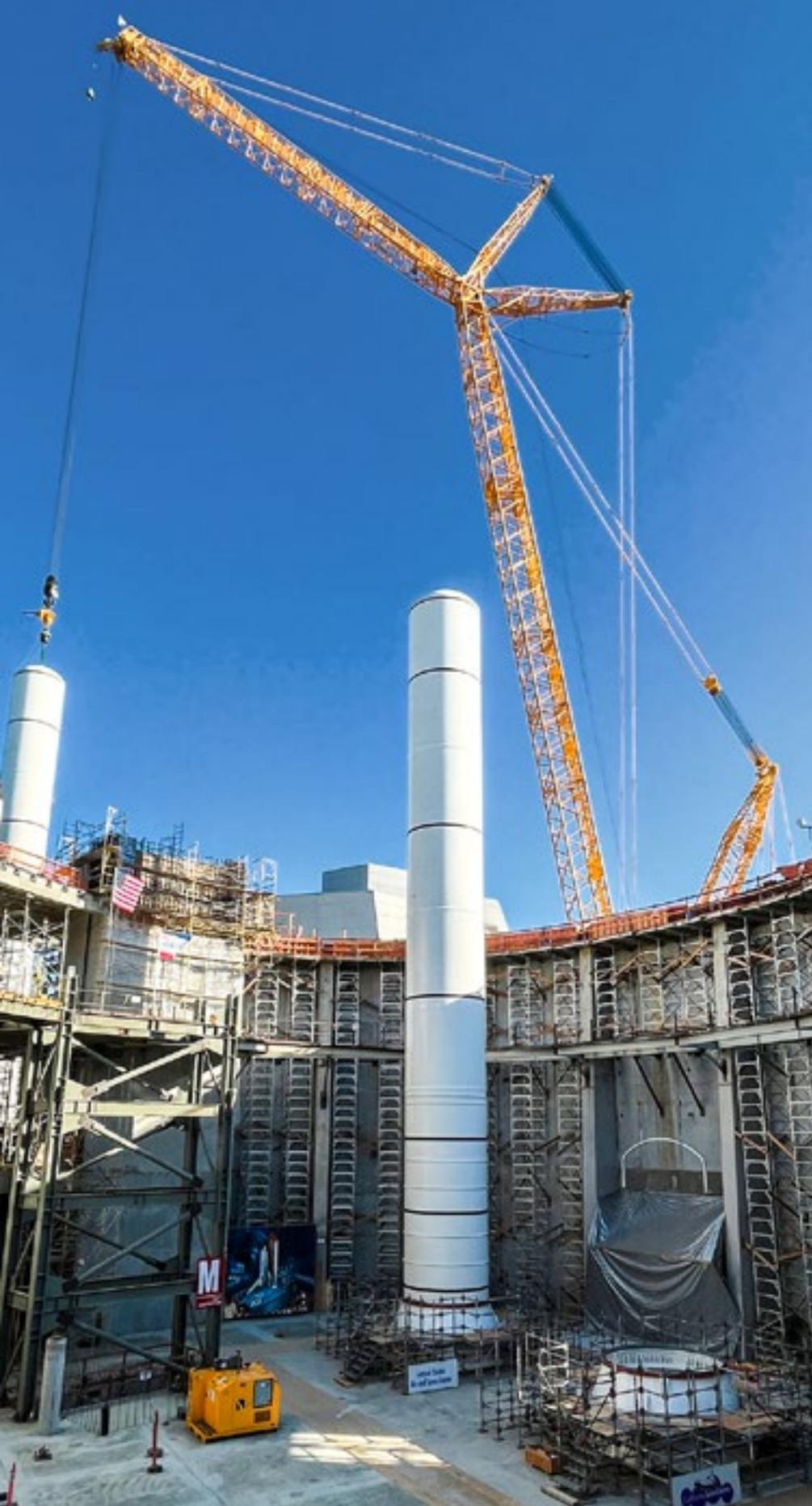
móvil LTM 1160-5.2 para asistir a la LR 1750/2 y así elevar el depósito de combustible de 46 metros de longitud, el componente de mayor tamaño, y los cohetes de combustible sólido. Ambas grúas demostraron sensibilidad y precisión al elevar y depositar los componentes.
