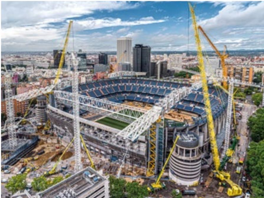
En total, más de veinte grúas móviles y sobre orugas Liebherr con capacidades de elevación desde 40 hasta 1200 toneladas estuvieron en funcionamiento en la obra. La cadena triple de grúas sobre orugas con una LR 1800-1.0 de Eurogrúas 2000, así como una LR 1600/2 y una LR 1600/2-W de Grúas Aguilar ofrecieron un potente rendimiento. Estuvieron permanentemente in situ de junio a octubre de 2020 y realizaron una gran variedad de izajes.
