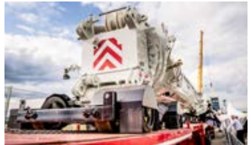
Der Rollwagen mit Kettenantrieb schiebt den Ausleger zur Montage an den Kran heran.
