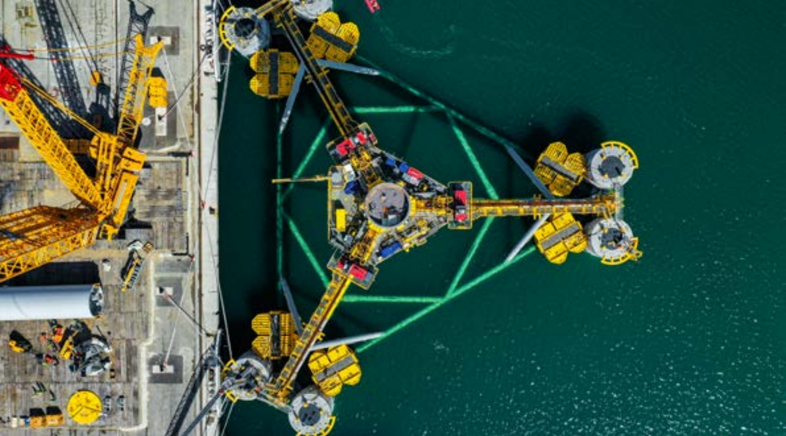
Schwimmende Windturbinen können bei einer Wassertiefe von bis zu 300 Metern mit Stahlseilen am Meeresboden verankert werden. Foto: Iann Hanning
