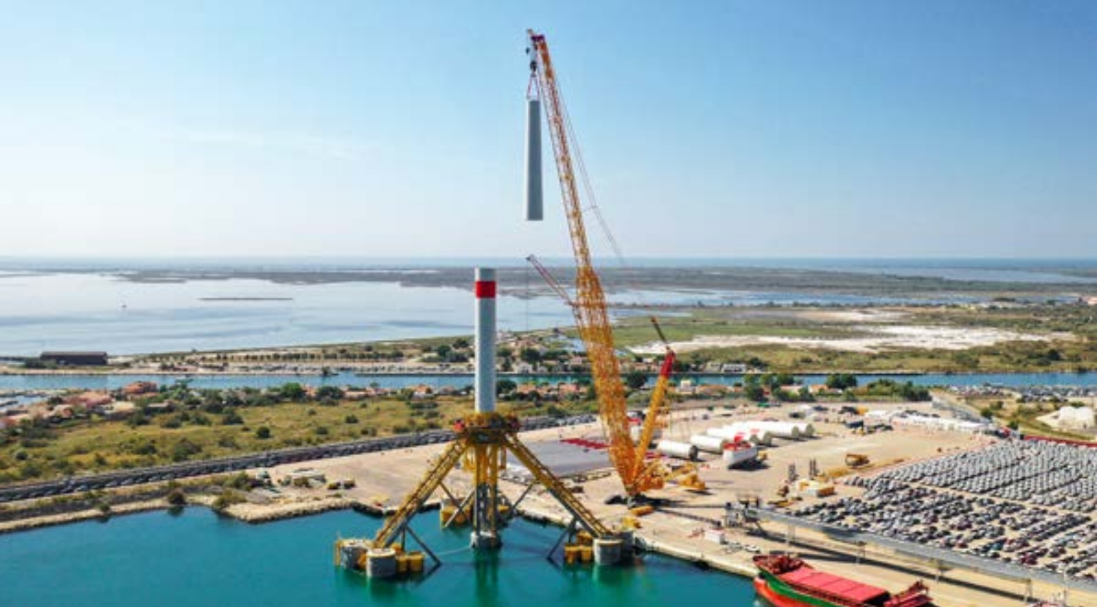
Una grúa sobre orugas Liebherr LR 11350 monta tres aerogeneradores de 8,4 megavatios sobre plataformas flotantes en el puerto de Port-Saint-Louis-du-Rhône
