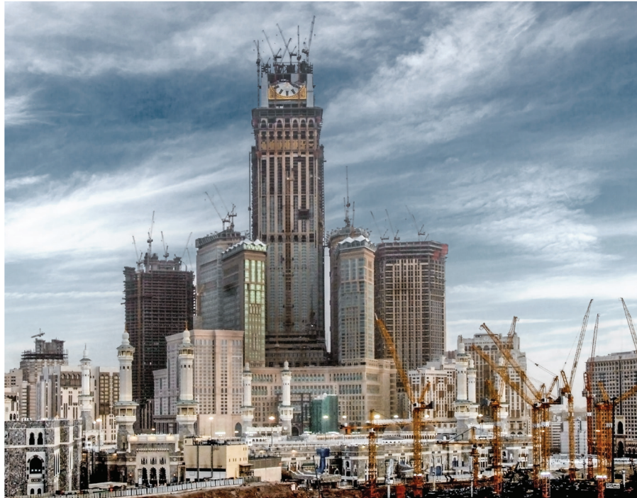
A whole fleet of Liebherr tower cranes building the Clock Tower in Makkah. أسطول كامل من الرافعات البرجية من ليبهير أثناء بناء برج الساعة في مكة المكرمة.
