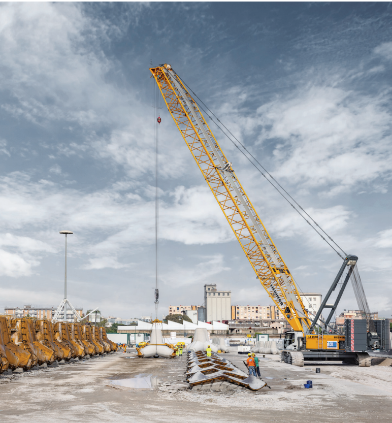
The LR 1300.1 SX crawler crane laying heavy blocks for harbour Protection in Naples (Italy) الرافعة المجهزة LR 1300.1 SX أثناء وضع الكتل الثقيلة لحماية الميناء في نابولي (إيطاليا)
