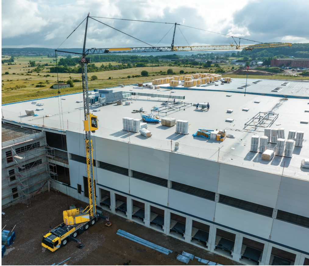
The specialist concept makes the MK cranes mobile and extremely compact. This enables them to achieve a high reach, as demonstrated in Gießen (Germany). المفهوم المتخصص يجعل رافعات MK متحركة وصغيرة الحجم للغاية. وذلك يمكنها من الوصول لمسافات عالية، كما هو موضح في مدينة غيسن (ألمانيا).
