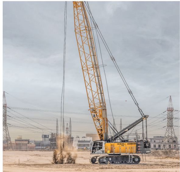
An HS 8100.1 carrying out dynamic compaction work in Kuwait رافعة HS 8100.1 تنفذ أعمال الدمك الديناميكي في الكويت
