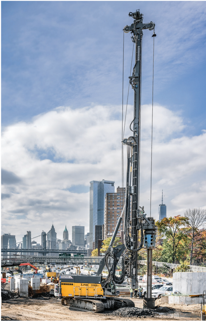
Kelly drilling with the piling and drilling rig LRB 355.1 in Manhattan, New York (USA) الحفر بنظام كيلي باستخدام آلات دق الركائز والحفر LRB 355.1 في مانهاتن، نيويورك، الولايات المتحدة الأمريكية
