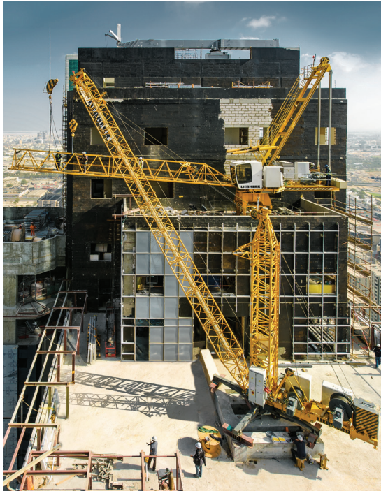
The Derrick service ensures fast and safe dismantling after the build is done. تضمن رافعة ديريك تفكيك الرافعات بسرعة وأمان بعد اكتمال البناء.
