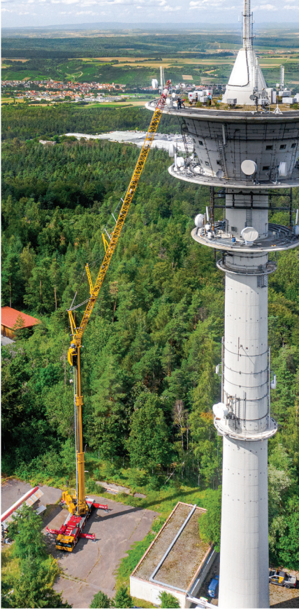
The MK 140 in luffing mode during the exchange of antenna technology of a telecommunications tower الرافعة MK 140 في الوضع المائل للذراع أثناء استبدال تكنولوجيا الهوائيات في برج الاتصالات
