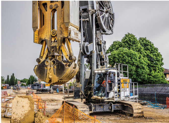
The LBX 600, carrier machine for slurry wall operation, in action on a construction site in Forlì (Italy) المعدة LBX 600 حاملة حفار الجدران. أثناء العمل في موقع إنشائي بمدينة فورلي (إيطاليا)
