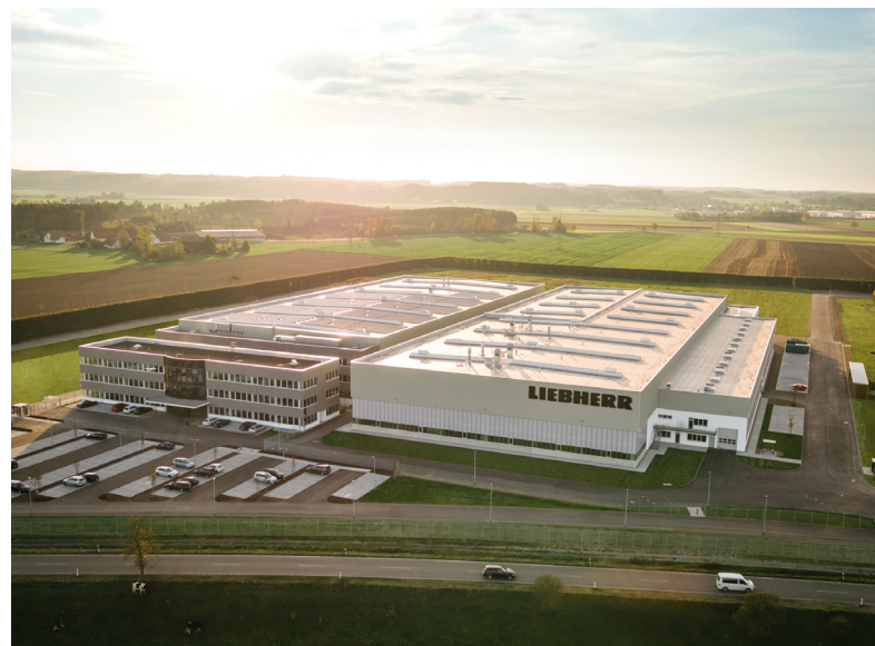
Abbildung 2: Das Produktionswerk der Liebherr-Components Kirchdorf GmbH am Standort Oberopfingen Hier sind seit 2017 Montage, Logistik, Lackierzentrum und ein Großteil der Verwaltung angesiedelt.
